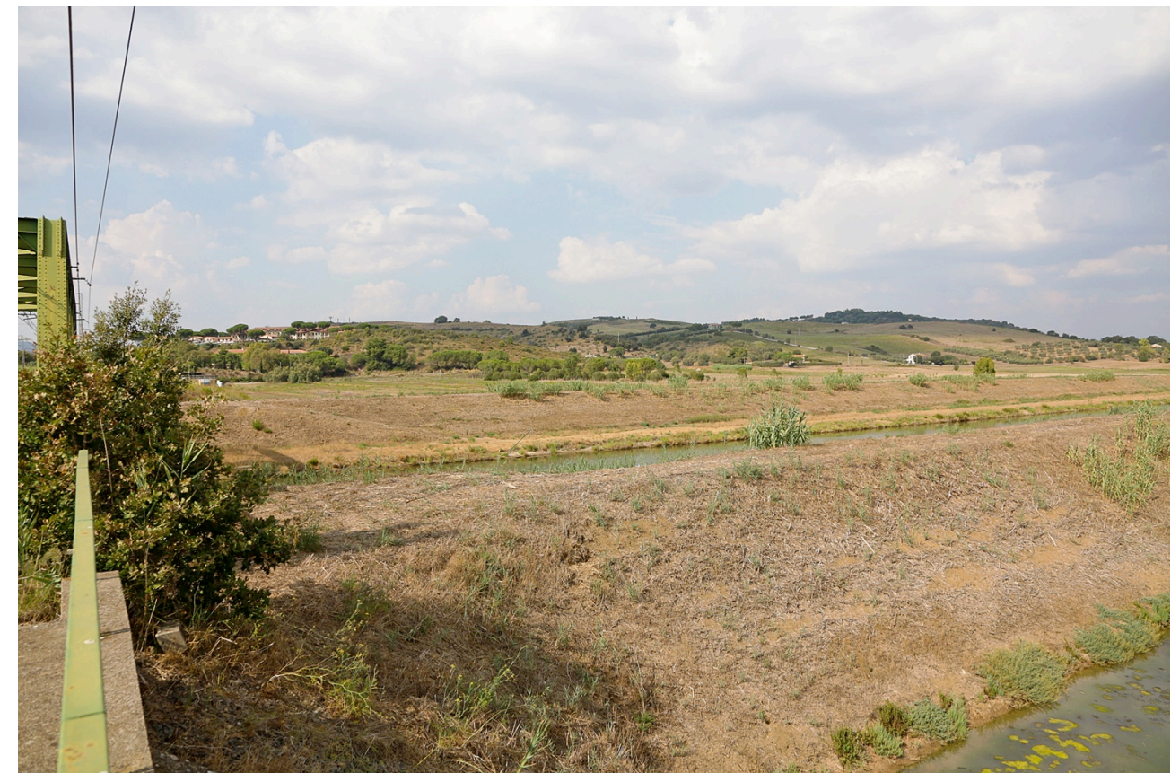
Figura 2-9 - Ponte ferroviario sull'Osa
