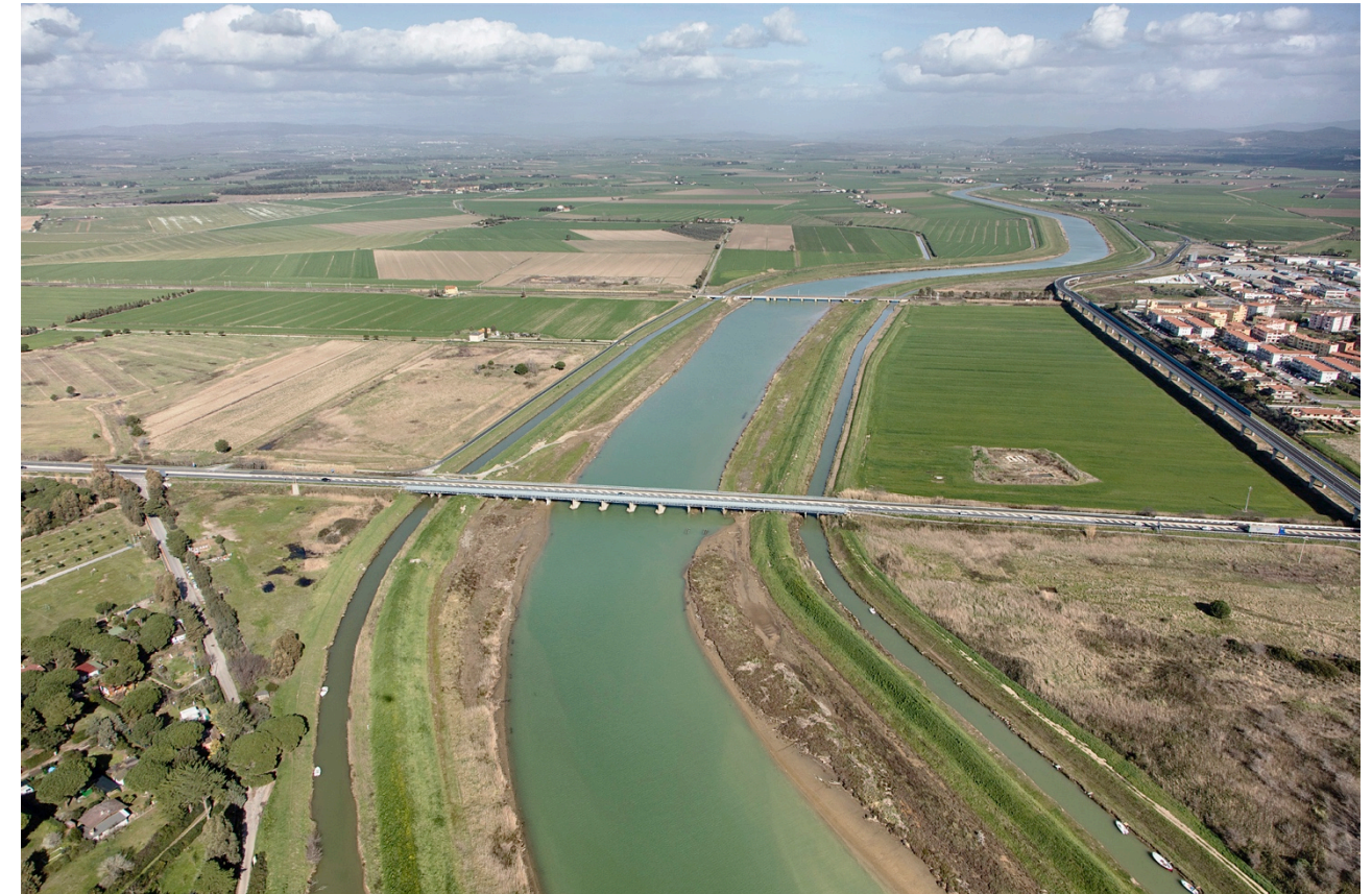
Figura 2-7 –Ponti sul Fiume Albegna – stato attuale.
