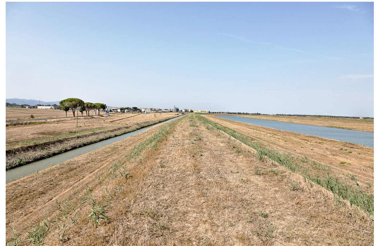
Figura 2-10 – Argine sinistro del Fiume Albegna
