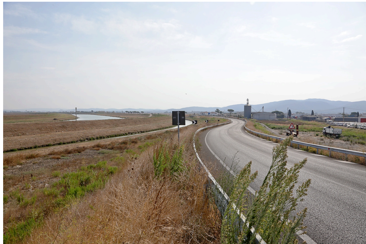
Figura 2-6 – Argine sinistro del Fiume Albegna
