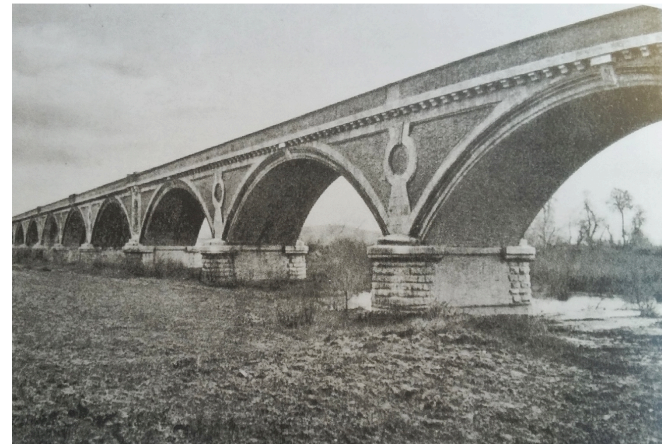
Figura 3-12 - Ponte sul Fiume Ombrone
